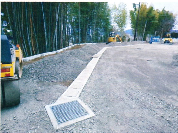
排水溝を作り雨水を市道の側溝に流します
