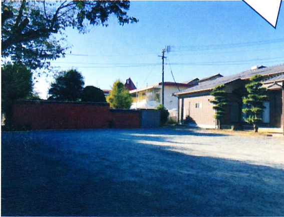
工事前、この中央に大きな水たまりができていました
